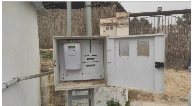
Contador eléctrico apoyado sobre poste metálico junto al sondeo para alimentación eléctrica de la bomba
