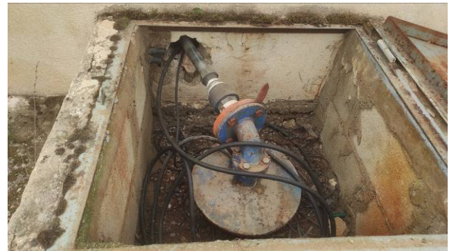
Varias vistas del sondeo con arqueta y tapa superficial
