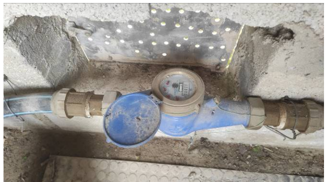
Varias vistas de la caseta de instalaciones en su estado actual, aspecto interior con contador volumétrico y cuadro eléctrico
