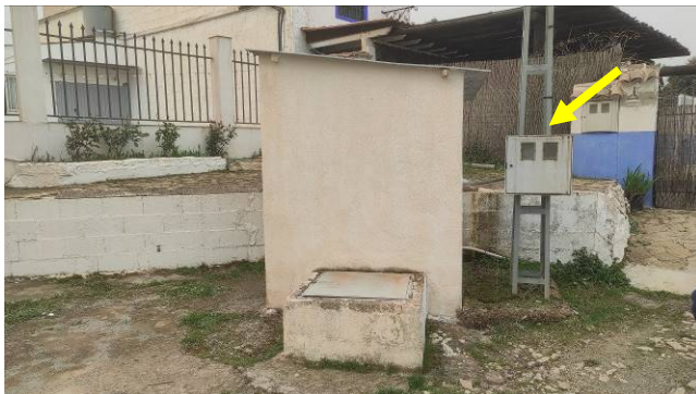
Contador eléctrico apoyado sobre poste metálico junto al sondeo para alimentación eléctrica de la bomba
