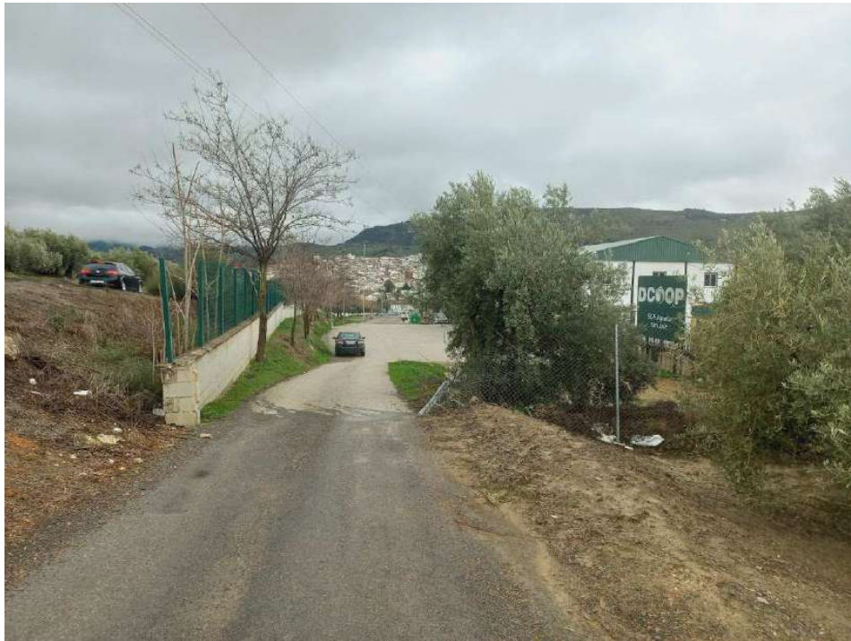
Figura 1.- Vista desde el extremo Noroeste del Área de Reserva, colindante con el Polígono Industrial, desde el camino existente junto a la carretera JA-4314, límite de los terrenos destinados a ampliarlo.
